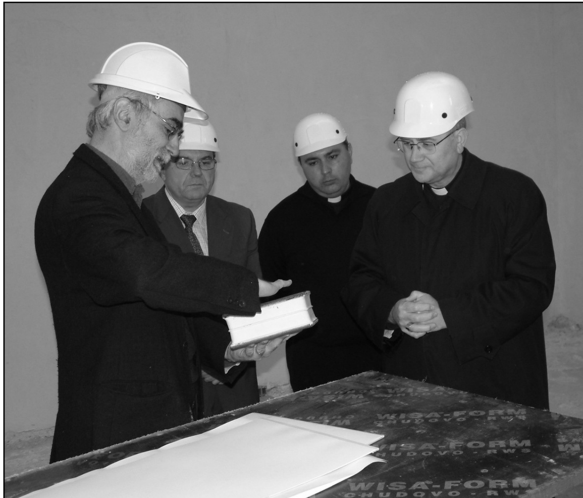
El obispo de Almería, Adolfo González visita in situ las obras de la nueva iglesia
