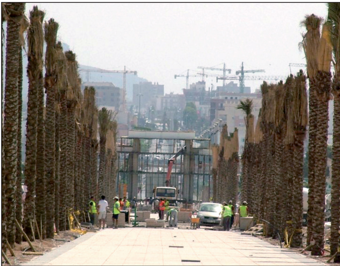
Obras del nuevo bulevar Ciudad de V́icar / Comarcal
