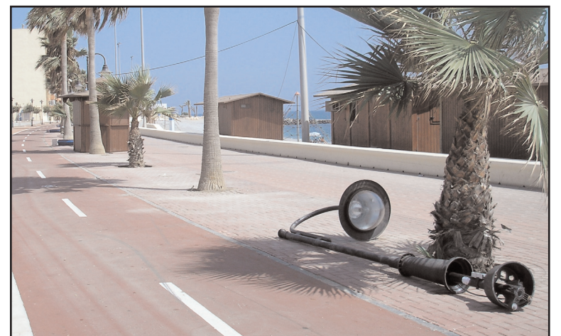
Daños ocasionados en el pago del lugar /Comarcal
