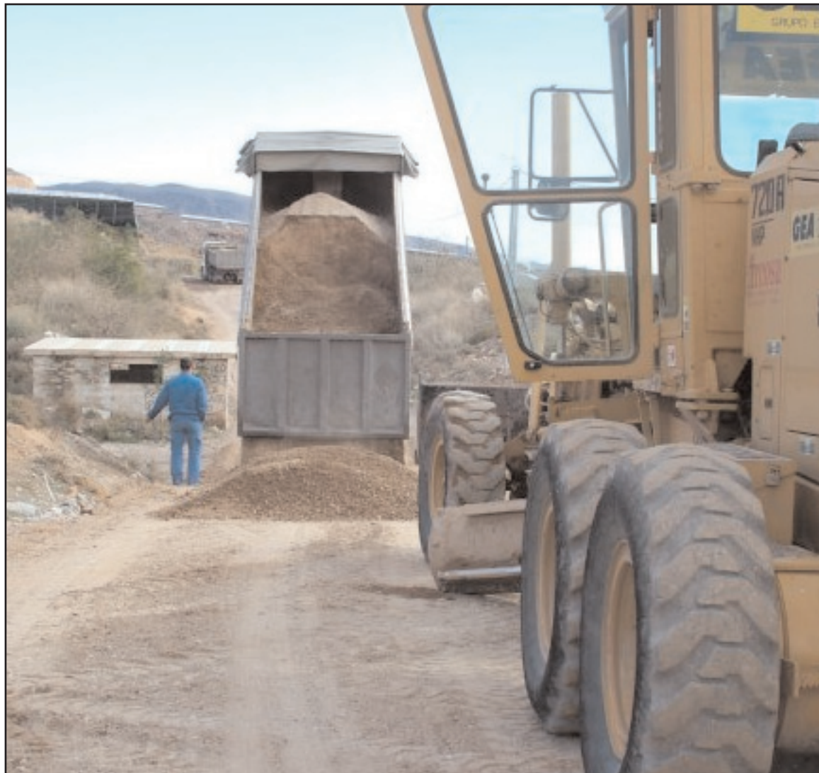
Asfaltado de caminos rurales en Vúcar /Comarcal30
