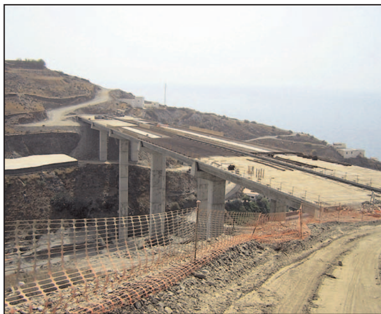
Obras de la autovia del mediterráneo ( Adra )
